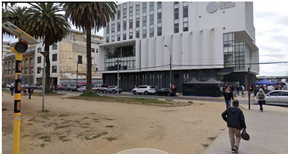
Figura 2: punto de encuentro en el bandejón Av. Brasil, frente a Escuela de Ingeniería Civil y Construcción. Elaboración propia.
