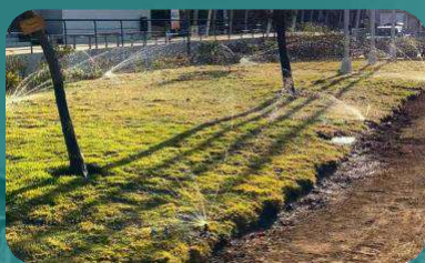
PUCV avanza hacia la eficiencia hídrica con riego tecnificado en Campus Curauma
